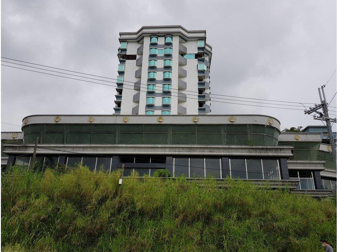
圖 1：大社區觀音山段翠屏路旁未完工渡假會館進行三拍
