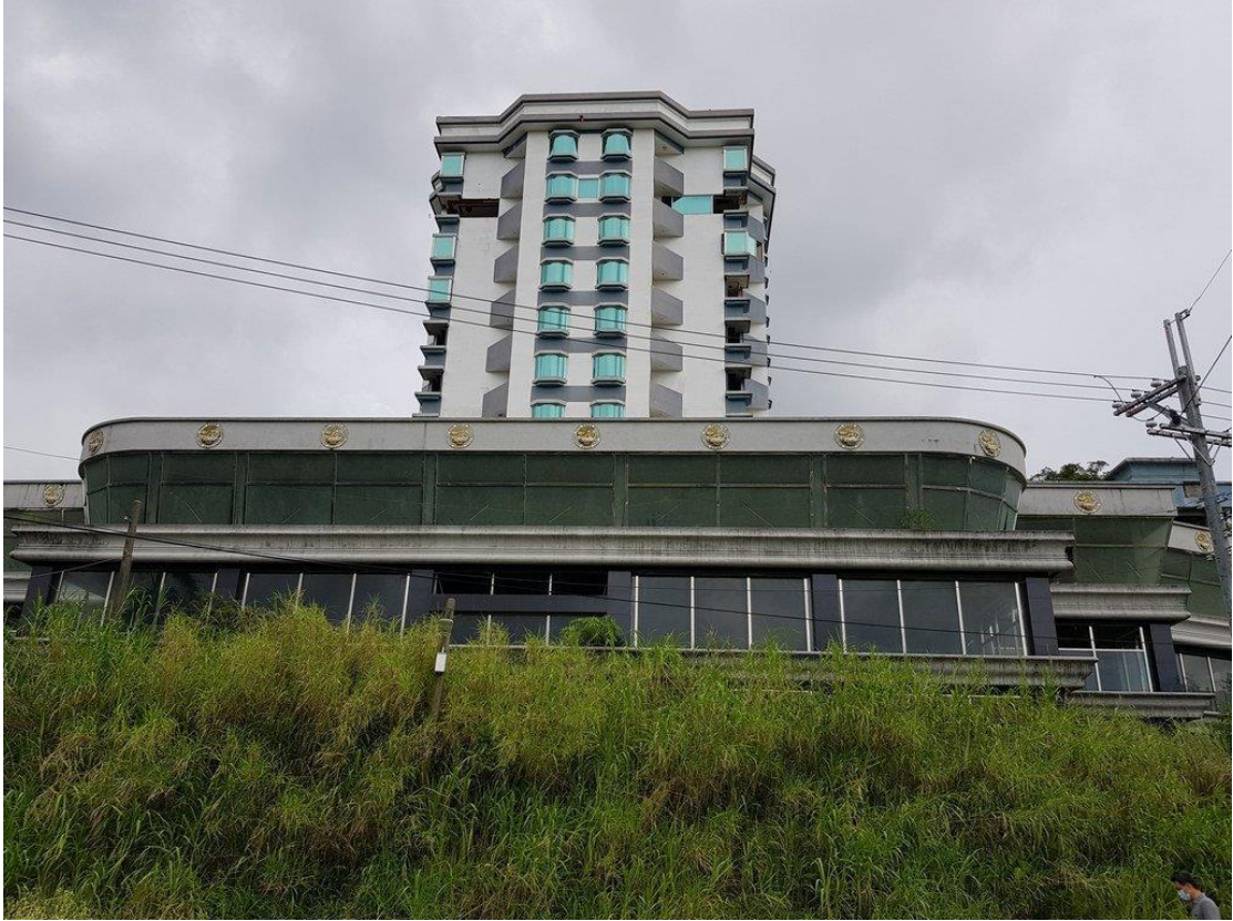
圖 1：大社區觀音山段翠屏路旁未完工渡假會館進行二拍
